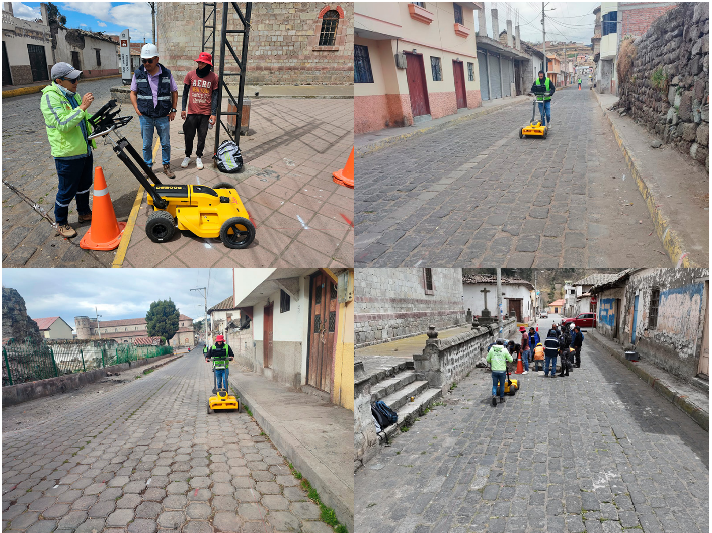
Figura 5 Levantamiento en campo
