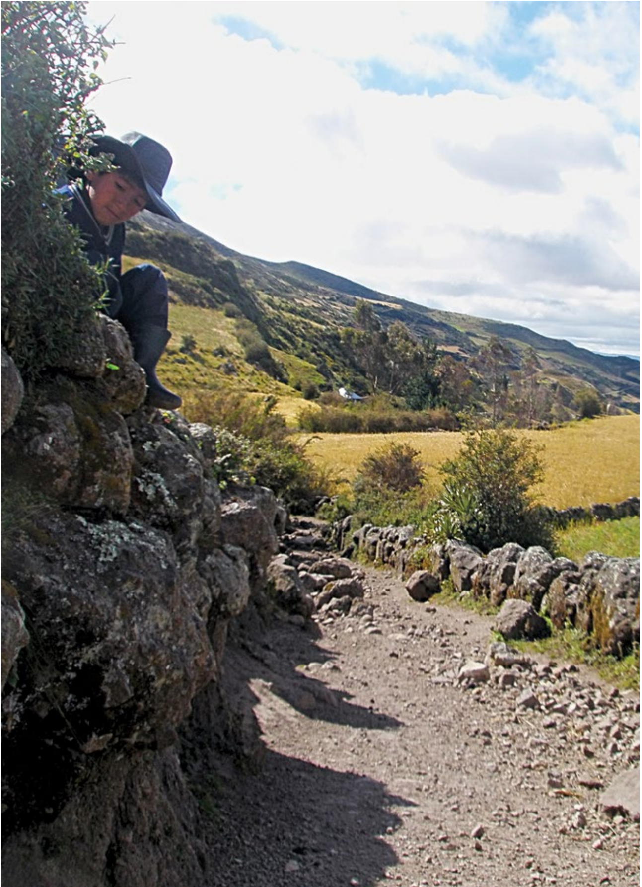
En el subtramo Achupallas-Ingapirca los caminos tienen buen estado y regular estado de conservación y aún se usan por las comunidades conexas Fotografía: Mónica Bolaños
